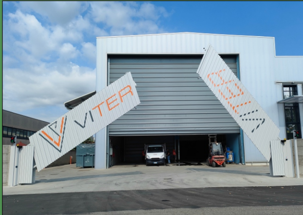
Trattamento rifiuti speciali Special waste treatment
